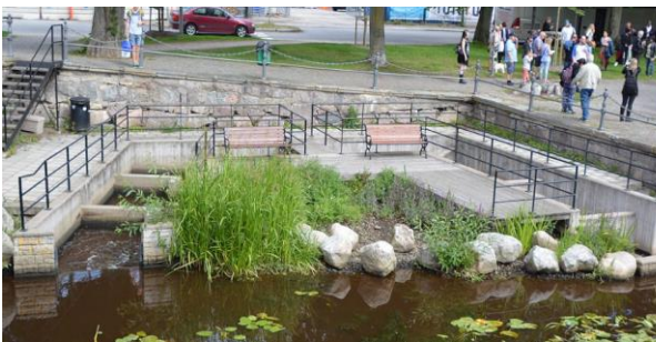
Fiskväg vid damm i Svartån vid Örebro Slott.
